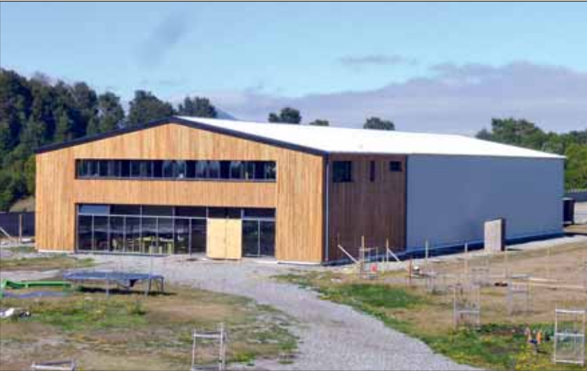
Die Werkstatt der Schreinerei Tronco Noble ist 50 m lang, 20 m breit und 9 m hoch. Die Innenwände der Halle wurden mit Stroh ausgefacht.
